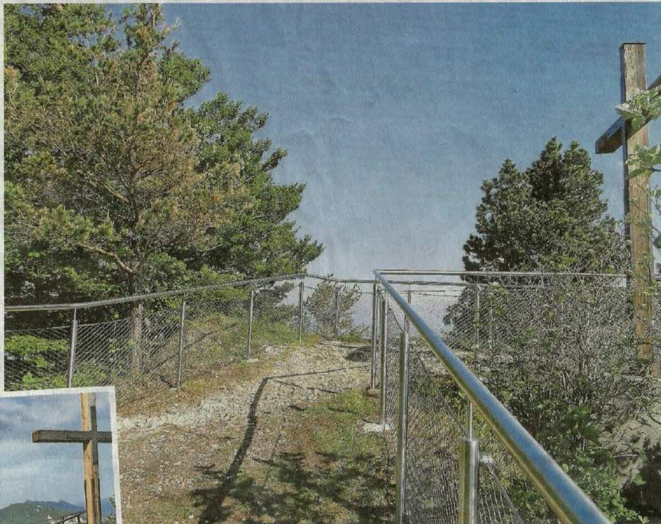
Das neu montierte Geländer auf der Roggenfluh ist mit einer Absturzsicherung ausgestattet. Unten: So sah das alte und teilweise verrostete Geländer aus.
