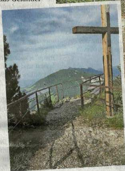
Das neu montierte Geländer auf der Roggenfluh ist mit einer Absturzsicherung ausgestattet. Unten: So sah das alte und teilweise verrostete Geländer aus.
