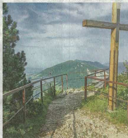
Existiert bloss noch auf Fotos und in Erinnerungen: das alte Geländer. Fotos: ZVG
