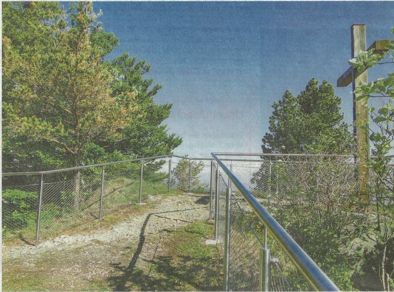
Neu mit Absturzsicherungsnetz: das Geländer auf der Roggenfluh.
